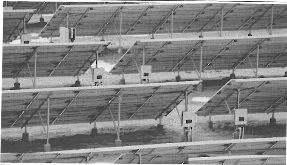
Montajul invertoarelor pe sol
